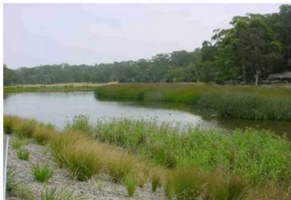
Зураг 2: Цагийн зүүний дагуу чиглэлээрх борооны цэцэрлэг, өвс ургах, биологийн хадгалалтын давхарга, биологийн хадгалалтын давхаргууд ( Эх сурвалж: Гуанмин дүүрэг дэх хөвөн хот байгуулалтыг хэрэгжүүлэх тэргүүлэгч бүлгийн алба, 2017 )
